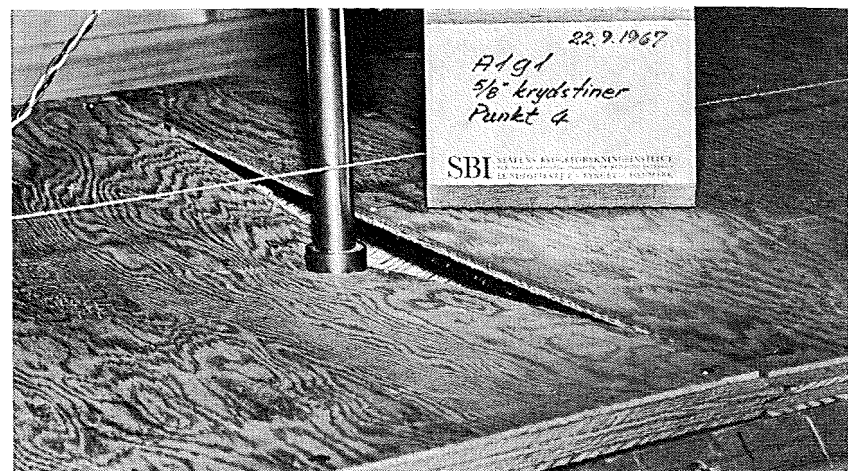
Typisk brud for statisk punktlast på krydsfinerundergulv uden understøtning af stød på tværs af bjælkerne. Bruddet indledes ved flækning i noten. Ved understøtning af alle pladekanter forøges både stivhed og styrke væsentligt.
